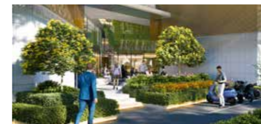
T&T GROUP Nhà điều hành The Millennia City | 1.744M 2
